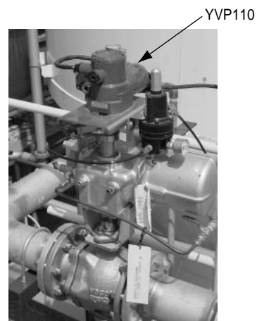
図1 実プラントに設置されたYVP110 (日本製紙株式会社 伏木工場殿 ご提供)
