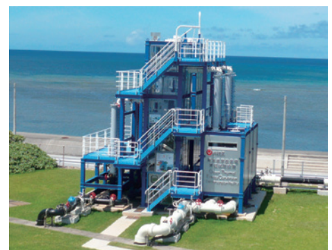
久米島の沖縄県海洋深層水研究所で稼働中の海洋温度差発電実証設備
